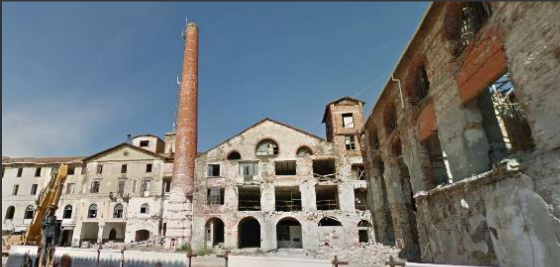
Stato attuale di abbandono e degrado delle vetrerie
